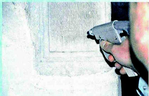
Weitere demonstrierte Einsatzbeispiele waren z.B. die Reinigung einer Steininschrift. Im unteren Bereich hebt sich die bereits gereinigte Oberfläche deutlich ab.
