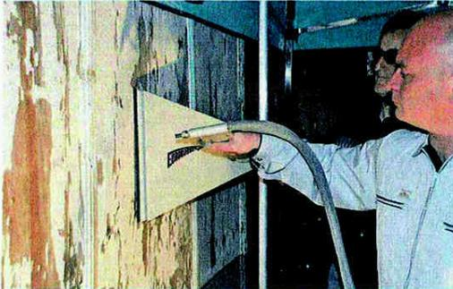
Jürgen Stenger (Eurorubber) bestrahlt die Wandvertäfelung aus Holz mit Granatsand der Körnung 200 Mesh (ca. 0,06 mm) bei einem Druck von ca. 1,5 bar und 450 l Pressluft pro Minute. Ernst Schartner (Mauracher, Partner von Eurorubber in Österreich) saugt das Strahlgut gleichzeitig auf.
